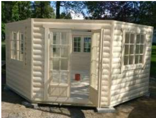
Seinät pystyssä odottamassa kattoelementtejä. Kuva Hermanni Sippola
