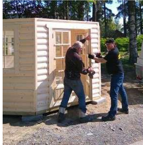
Seinäelementtejä asentamassa veljet Jari ja Sauli. Tässä tulee ovi paikalleen. Kuva Hermanni Sippola
