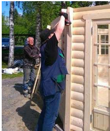
Akkuporalla olli käyttöä lähes joka vaiheessa. Vain kattosaumojen palat kiinnitettiin nitojalla. Eli siinäkin tekniikka pelasi. Kuva Hermanni Sippola
