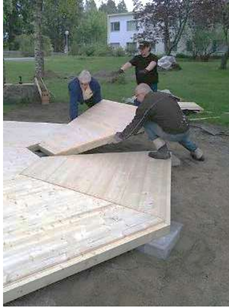
Pohjaan viimeinen elementti ja sitten pystyttämään. Kuva Hermanni Sippola
