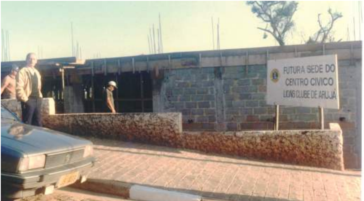
O CL. Januário vistoriando a Obra da Sede e Centro Cívico do Lions Clube de Arujá, primeiro piso erguido e pronto para laje, em meados de 1985.
